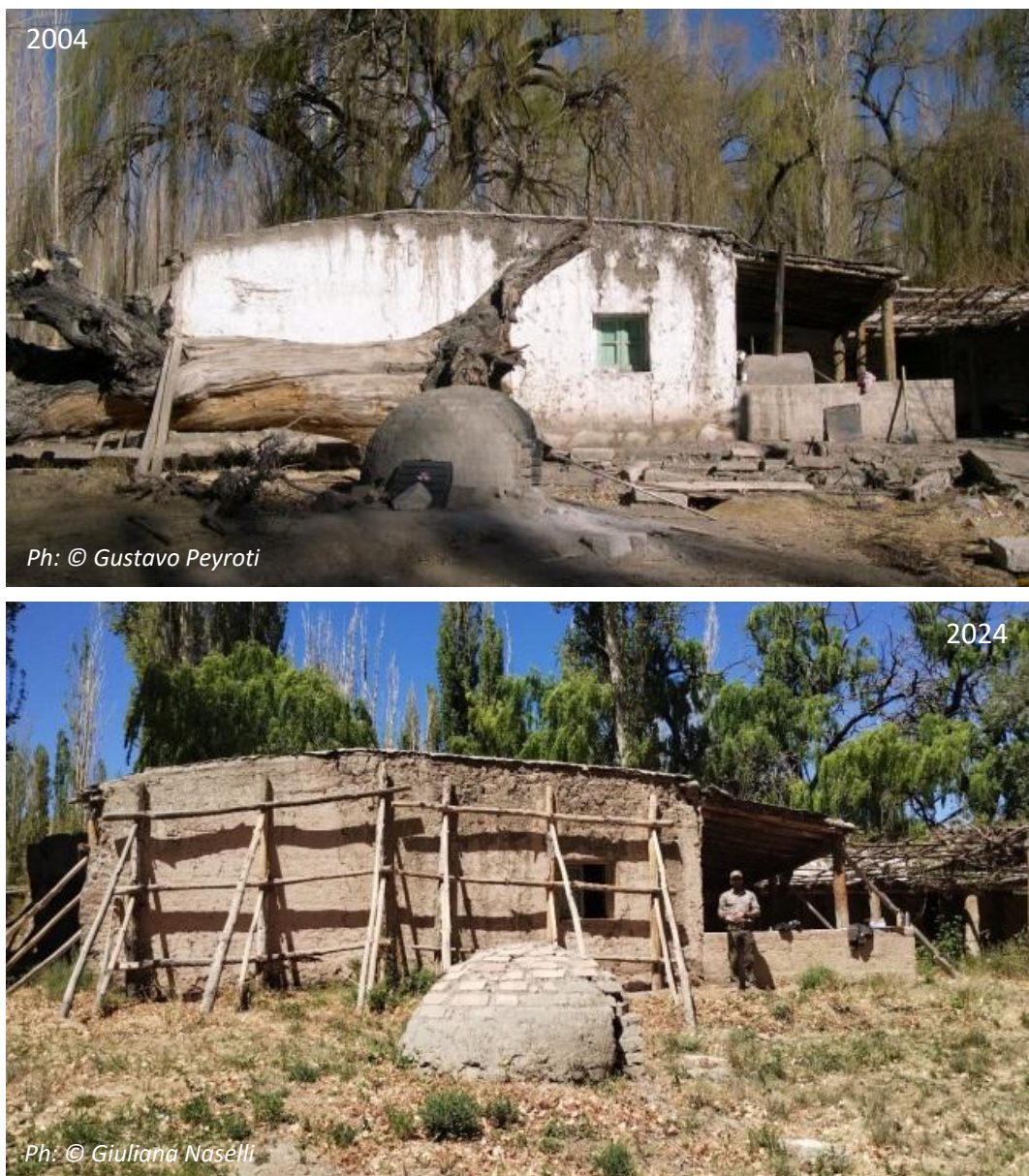
Figura 55: Vista del frente del casco en 2004 y en 2024
