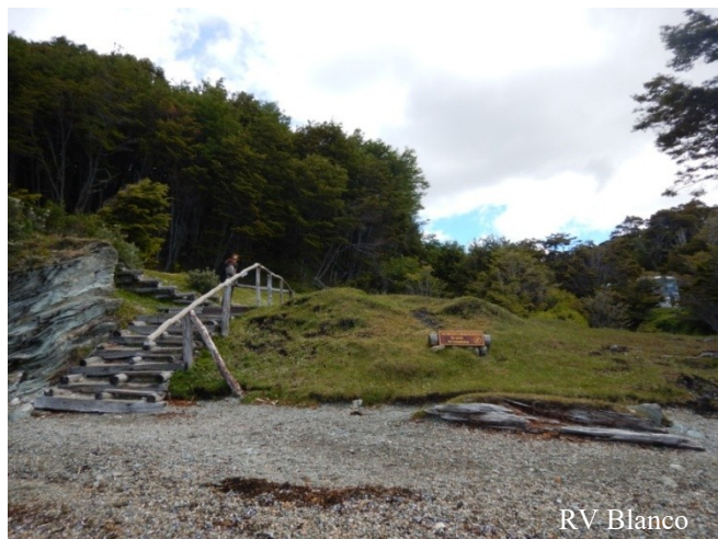
Figura 67. Entablado de un sector de la senda costera. Infraestructura construida para ordenar el tránsito de visitantes y evitar el pisoteo sobre un sitio arqueológico.
