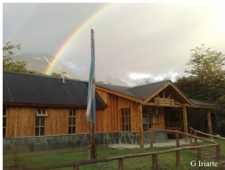
Figura 57. Instalaciones en portada de acceso al PNTF.
