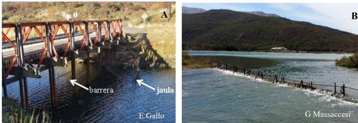
Figura 41. Barreras físicas para control de salmón Chinook en el río Ovando. A: en el puente; B: en la naciente.
